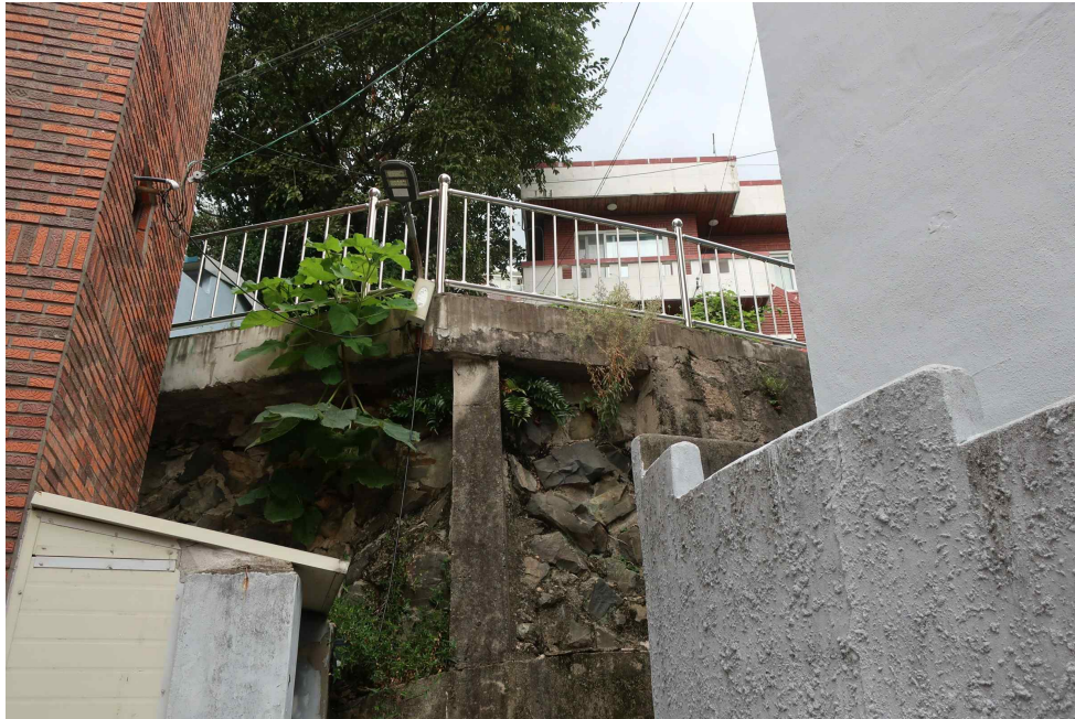
본건 및 주변 전경
