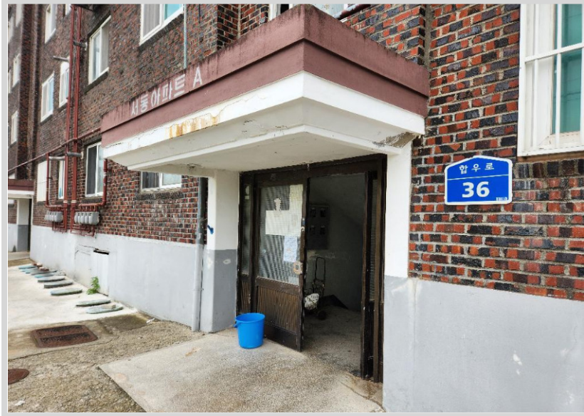
본건 소재 건물 출입구 전경
