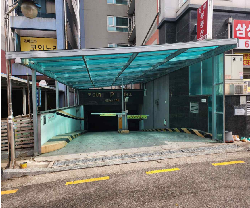
본건동 남서측 지하주차장 출입구 전경
