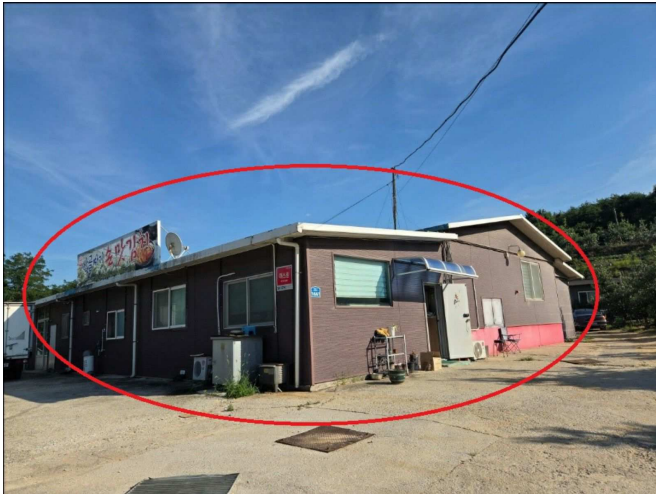
본건 건물 전체 전경
