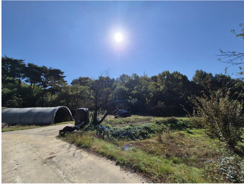
본건 전경(북동측에서 촬영)
