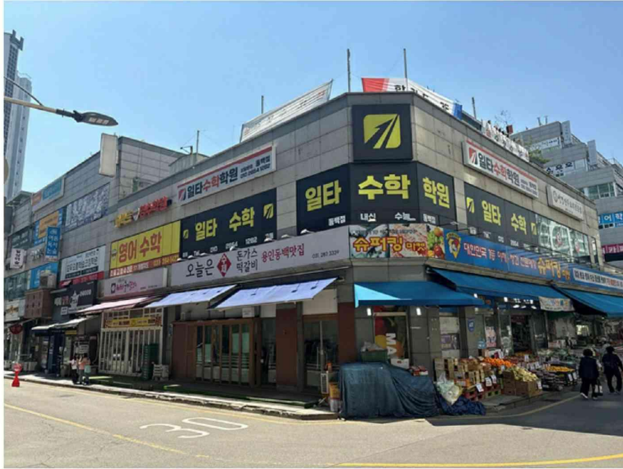
본건 건물 전경
