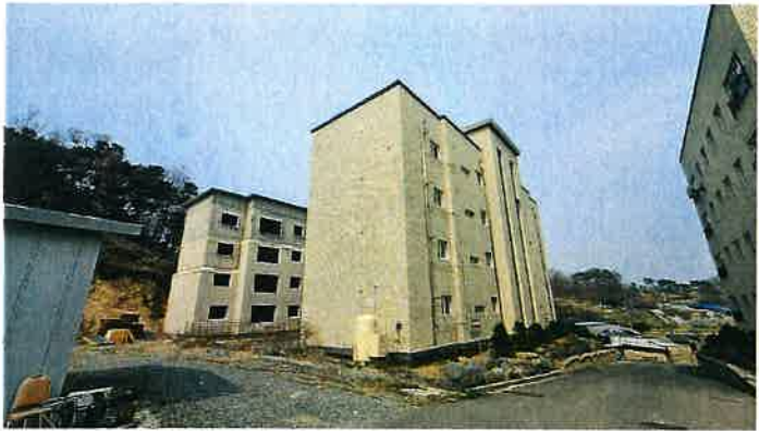
본건 단지내 전경
