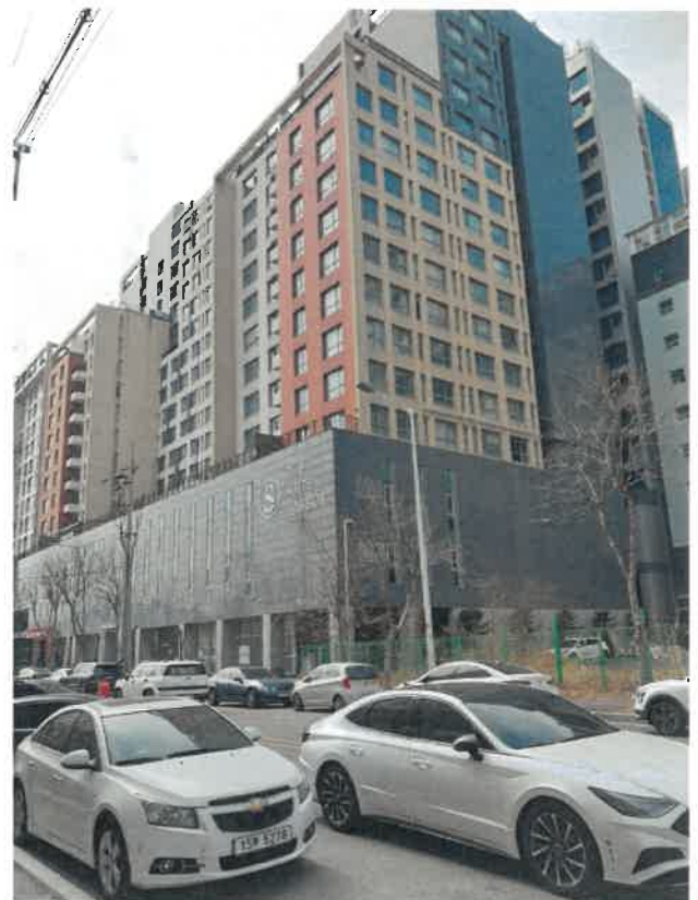
더스위트하버 빌딩 전체 전경(북동측 인근에서 촬영)
