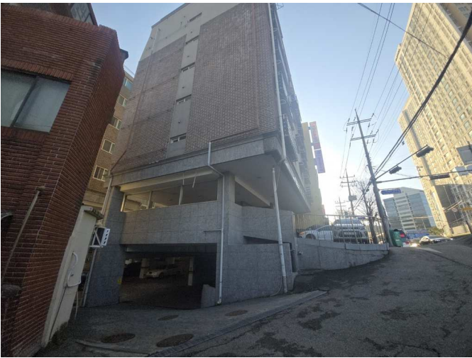
본건 건물 측면 전경
