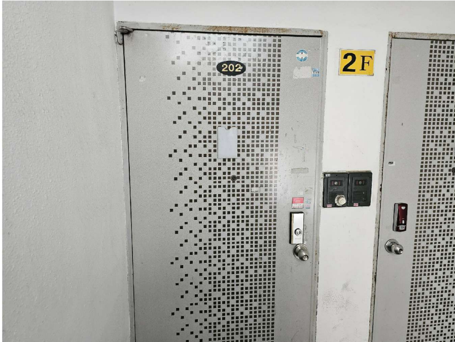
본건 출입문 전경
