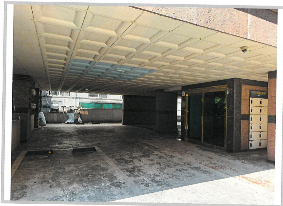
[본건 1층 주차장]
