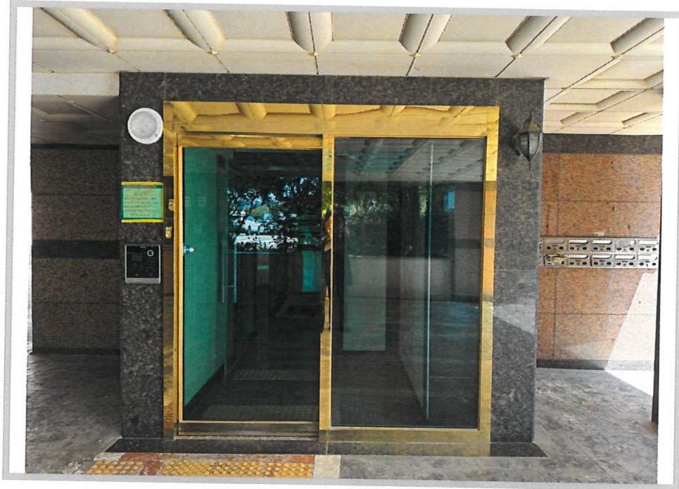
[본건 1층 출입구]
