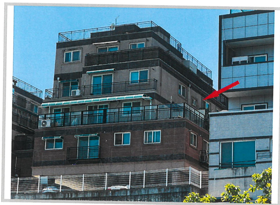
[본건 전경(북동측에서 촬영)]
