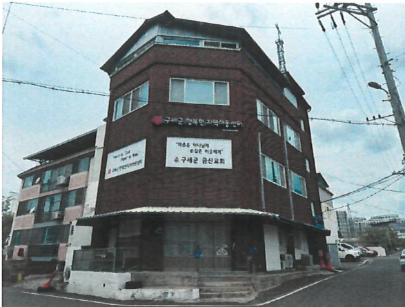
본건 기호(3) 건물 전경
